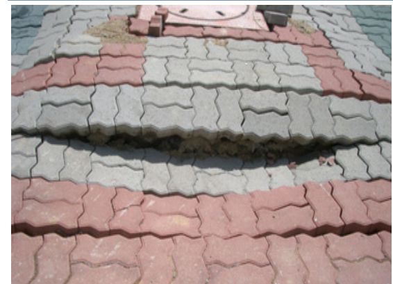
토사유출에 의한 흙막이 배면 지반침하 발생
